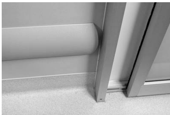
図 21 立ち上がり部分が巻き上げになっている廊下
