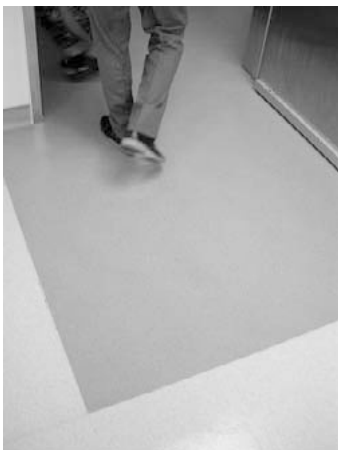
図12 手術室の一部まで施された滑り止め床材
